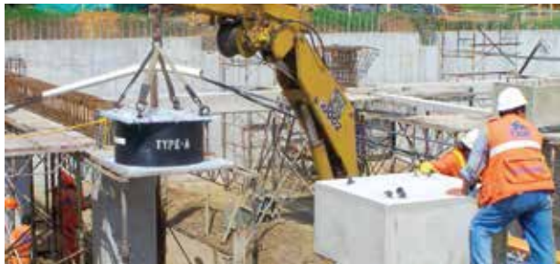
Clínica Confandi. Este hospital fue el primer edificio aislado sísmicamente en Colombia.
